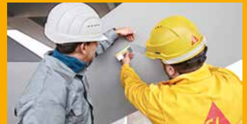
SERVICE UND BERATUNG AUF DER BAUSTELLE
