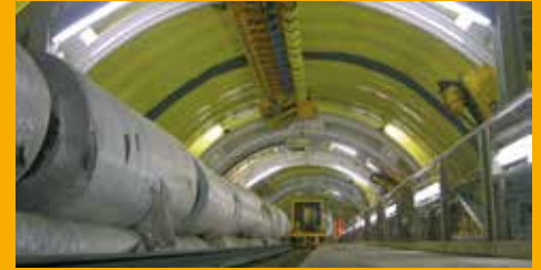
TUNNELBAU UND BAUWERKSABDICHTUNG
