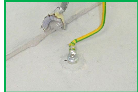
Gut geplanter Anschluss / an die Erdung fix angeschlossen
