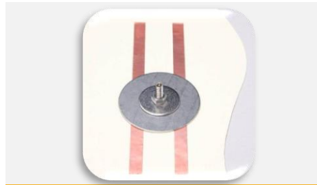
Ableitfahnen verkleben / mit Beilagscheiben Kontakt herstellen
