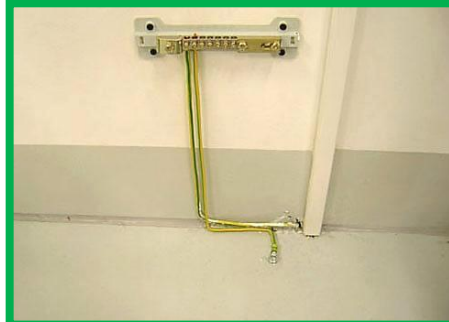
Gut geplanter Anschluss / an die Erdung fix angeschlossen
