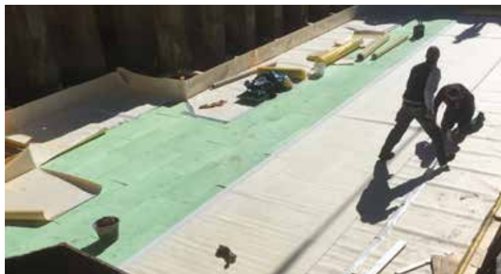
Bild 2: Horizontalabdichtung unter der Fundamentplatte durch SikaProof® A
