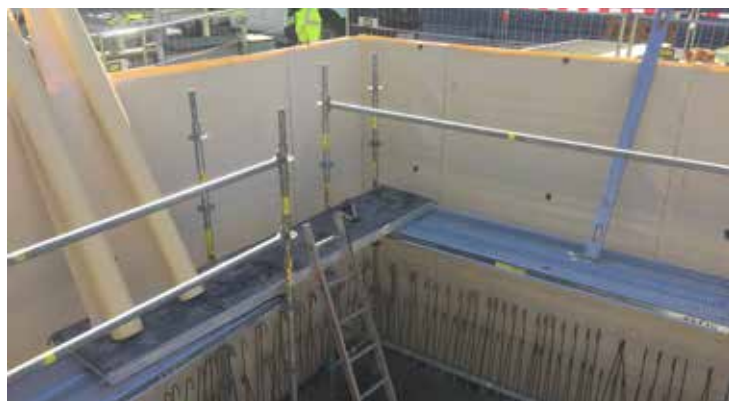
Bild 3: Sehr robuste und dauerhafte Abdichtung durch den stabilen und gleichmäßigen mechanischen Verbund
