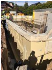
Dauerhafte Abdichtung der Kelleraußenwände (ca. 350 m 2 ) durch das SikaProof® A Abdichtungssystem
