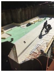
Horizontalabdichtung unter der Fundamentplatte durch SikaProof® A
