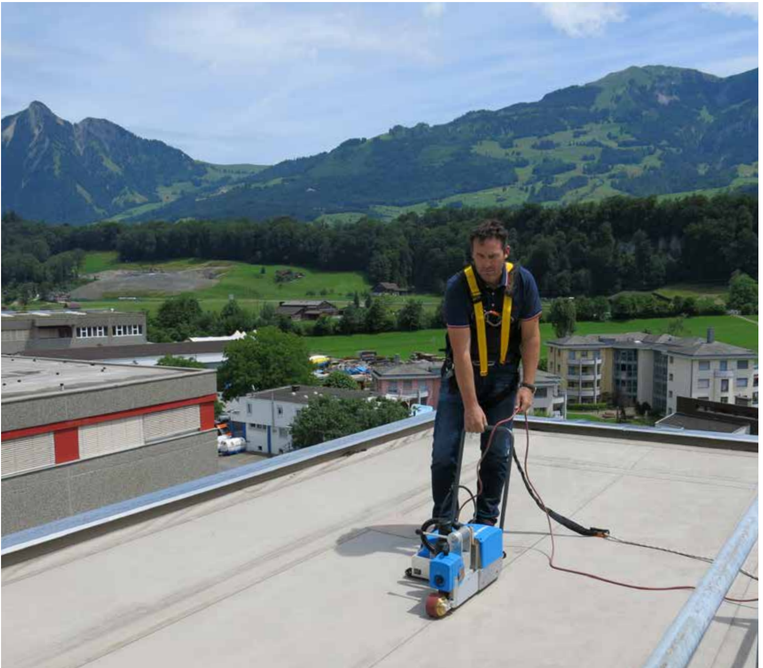
Sarnamatic-681 zum einfachen und sicheren Verschweißen von Dachabdichtungen.
