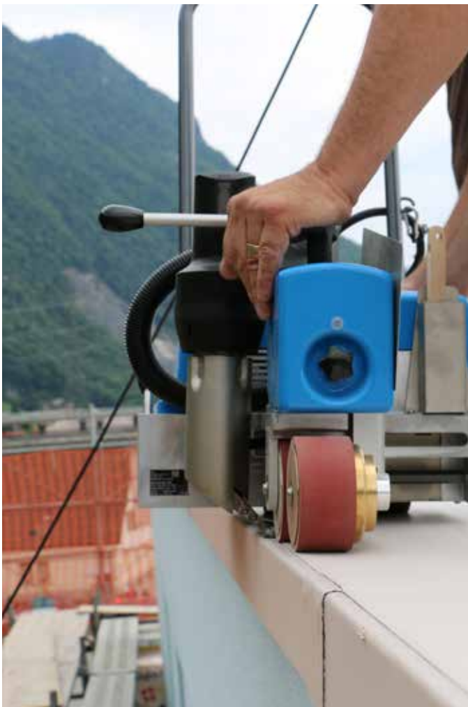
Verstellbare Lauf-/Andrückrollen ermöglichen das Schweißen nahe am Dachrand.
