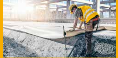
TUNNELBAU UND BAUWERKSABDICHTUNG
