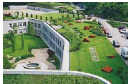
GRÜNSTATTGRAU ist heute die Kompetenzstelle für Bauwerksbegrünung.
